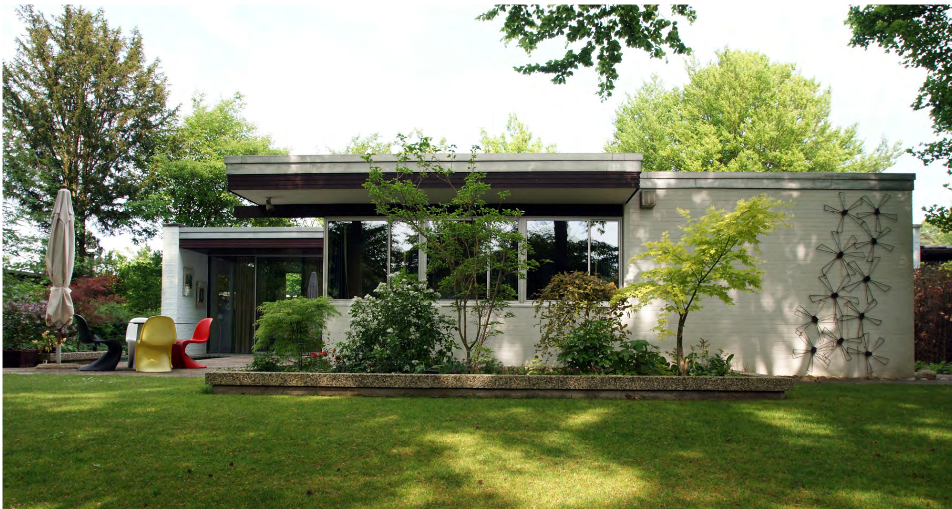
Architektenraumhaus: Markus Mehrfeld und Marco Sacchi haben ihren Neutra in liebevoller Kleinarbeit denkmalgerecht saniert. (Foto: Luise Rellensmann)
