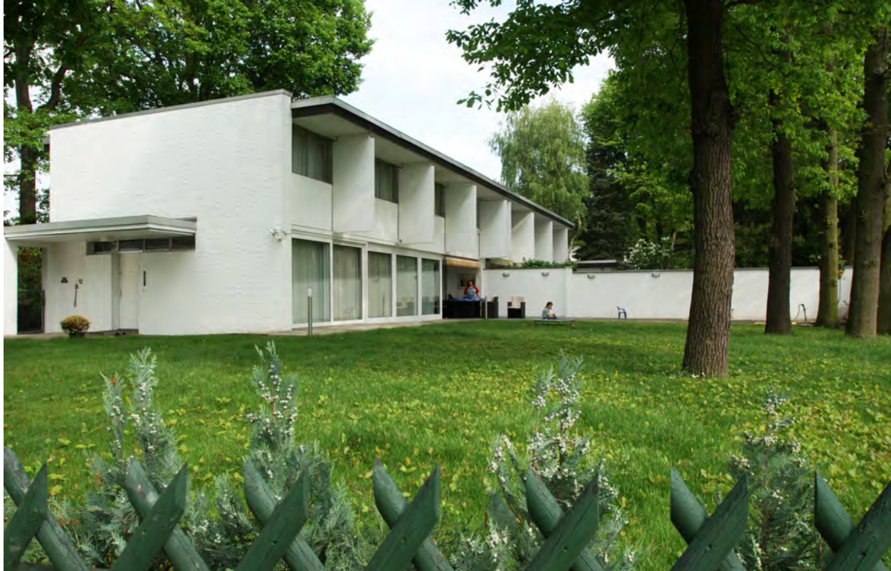
Idylle hinterm Jägerzaun: Der Grundrisstyp C ist mit 160 Quadratmetern auf zwei Etagen der größte von allen Siedlungshäusern. (Foto: Luise Rellensmann)
