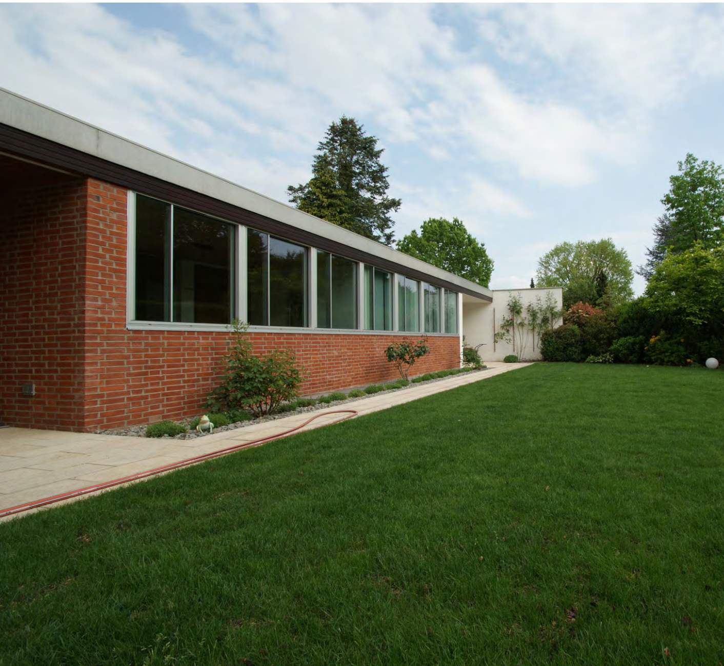
Diese Bewohner haben ihre Fenster mit schmalen Aluminiumprofilen denkmalgerecht saniert. (Foto: Luise Rellensmann)
