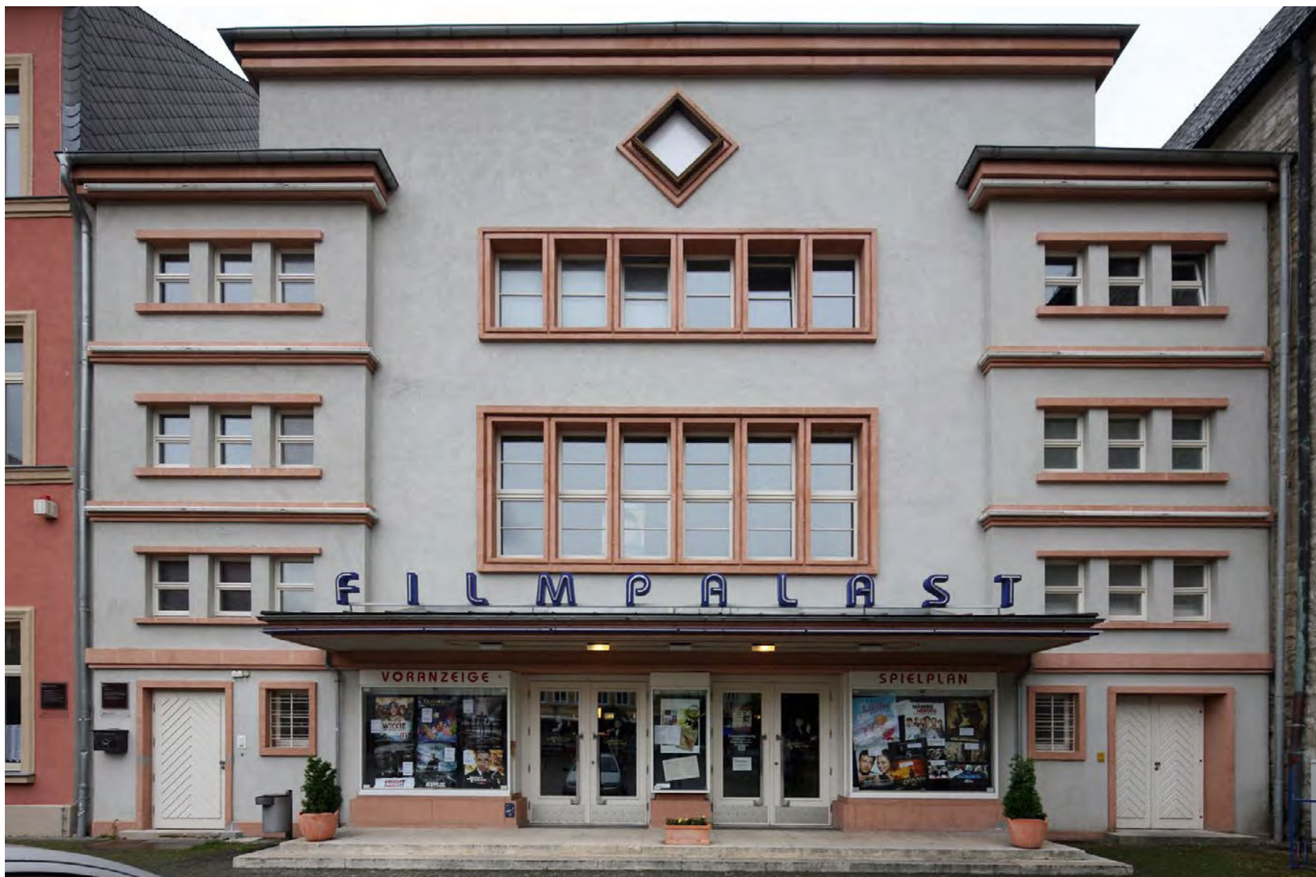
Der Filmpalast Ascherleben eröffnete im Jahr 1930 als modernes Tonfilmkino. Die streng komponierte Fassade zitiert die Bauhaus-Moderne, zwei vorspringende Seitenrisalite rahmen den Mittelteil des Gebäudes. Foto: -tze
