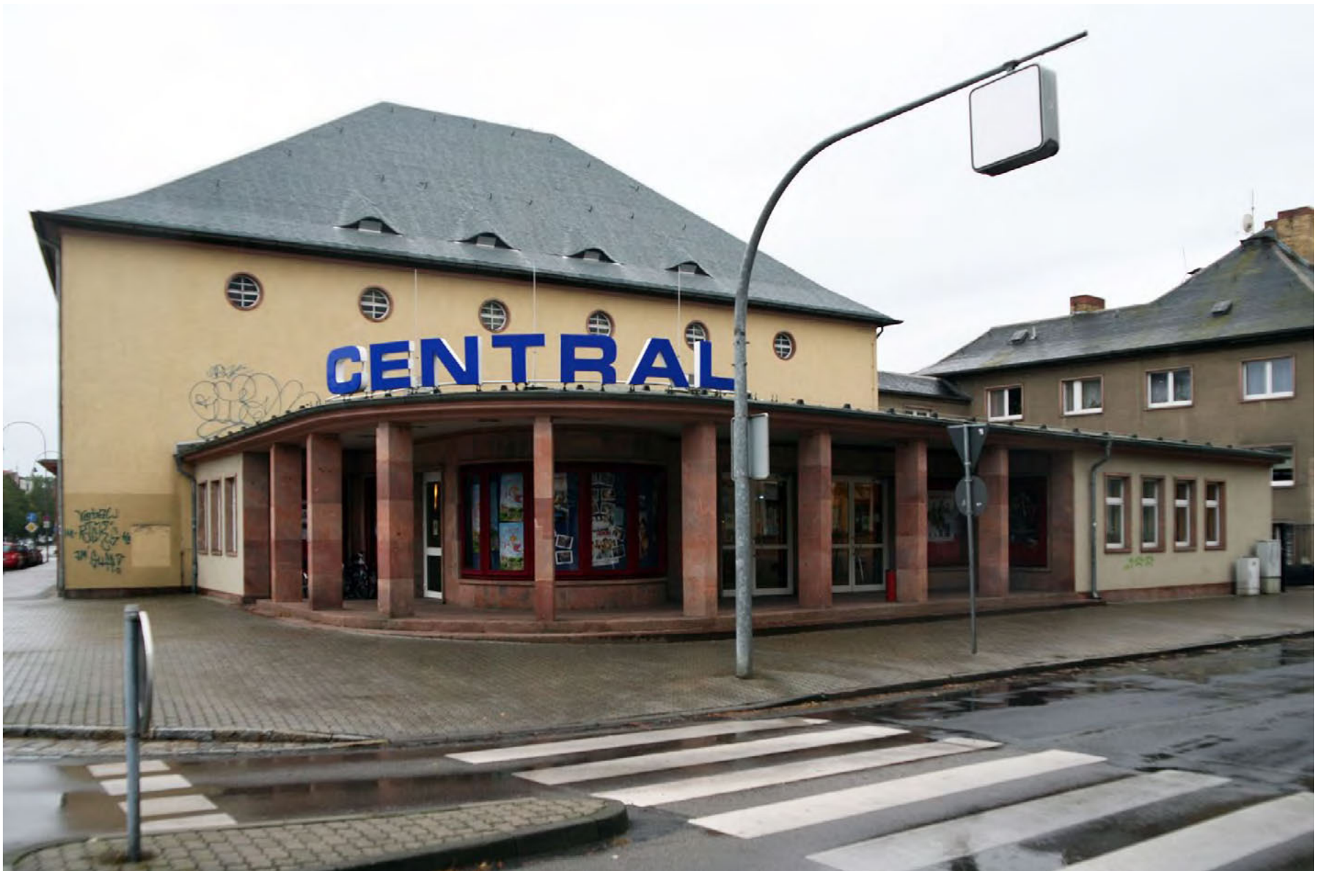
Das Central-Theater in Wittenberg (1937) besteht aus zwei Baukörpern: einem verputztem Mauerwerksbau im Heimatschutzstil und dem runden, vorspringenden Eingangsbereich. Foto: -tze
