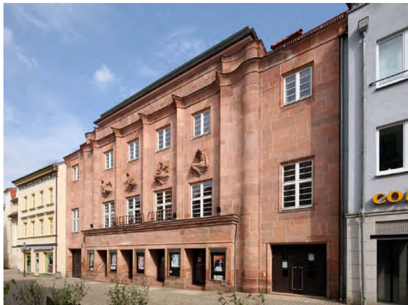
Die expressionistische Fassade aus Rochlitzer Porphyrtuff dominiert die angrenzende Bebauung. Fotos: -tze
