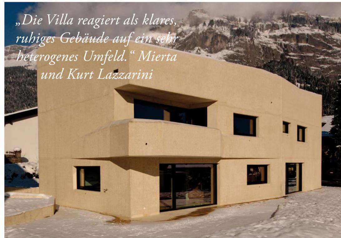
*Die Villa Crap la Tgina steht in einem der sehr heterogen bebauten Erweiterungsgebiete um Flims. Ihre Dachkante bezieht sich auf das Hochplateau des Flimsersteins, durch nachträgliches Stocken sollte der Beton einen „steinigen Charakter“ erhalten. Die gebrochene Oberfläche verändert sich im Licht.*
