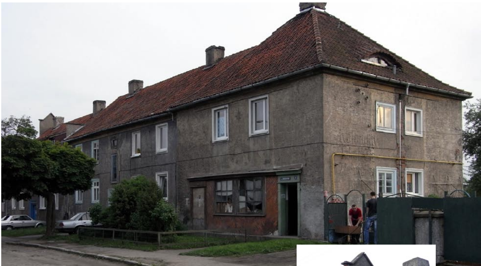
Das erste Haus der Bunten Reihe (Hausnummer 4) mit seinem ehemaligen Laden soll als „Testprojekt“ als Erstes instand gesetzt werden
