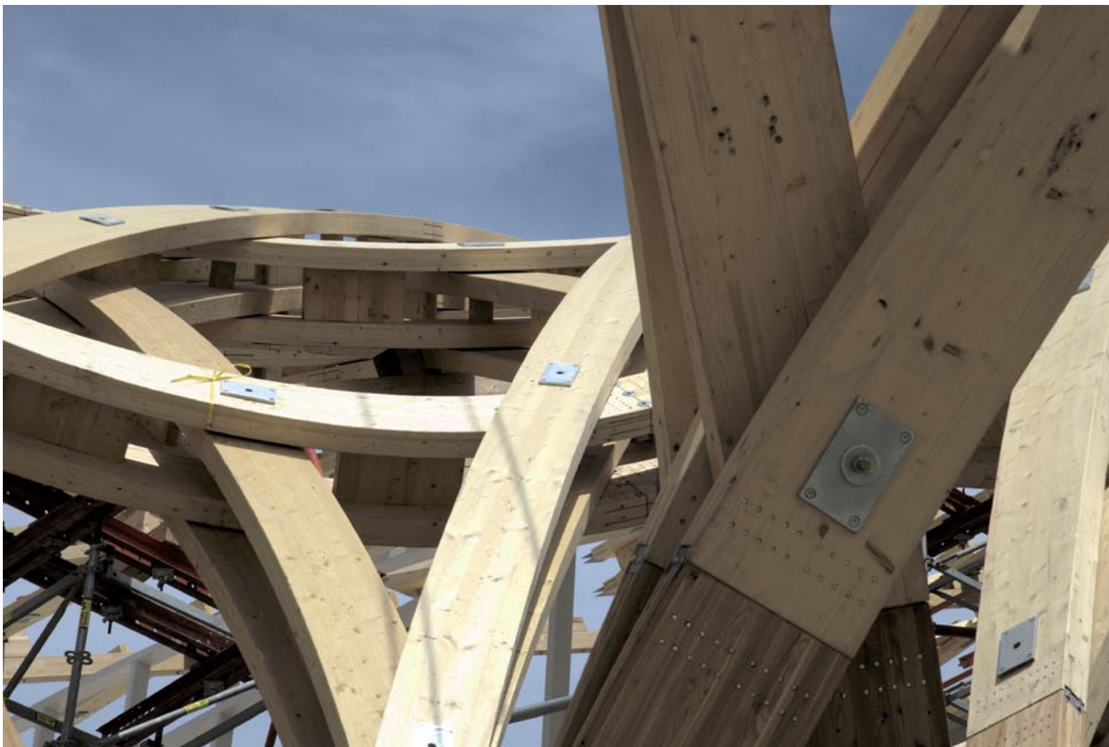
Beim Centre Pompidou in Metz wurden 7.000 Verbindungen passgenau positioniert
