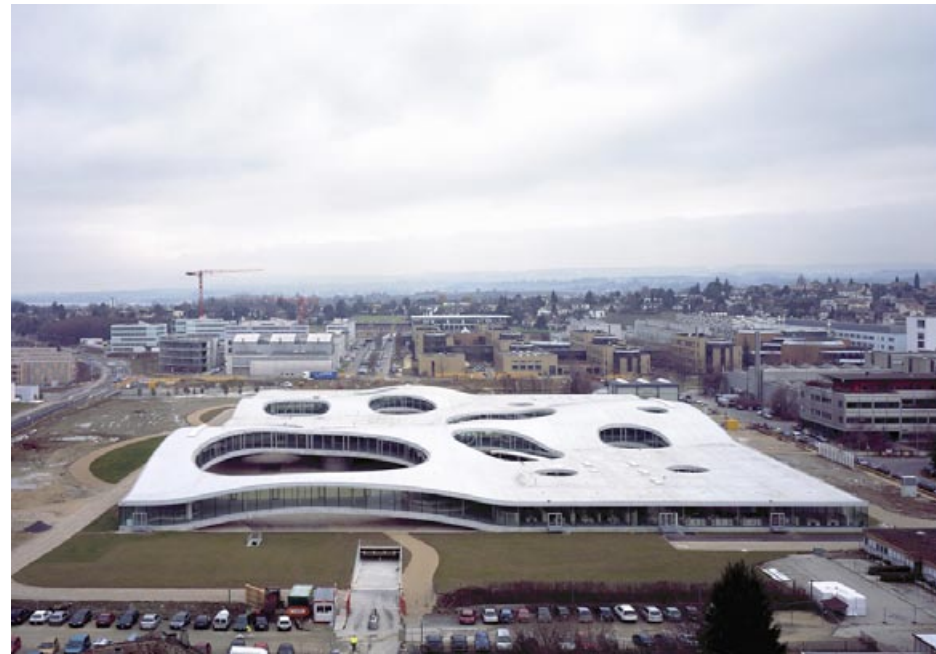
Das EPFL-Learning-Center in Lausanne von SANAA ist ein Stahlbetonbau, der ohne ein parametrisches Datenmodell für die Holzschalung nicht baubar gewesen wäre
