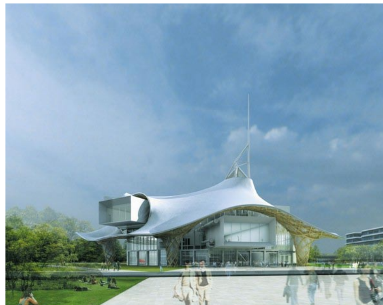
Das Dach des Centre Pompidou in Metz von Shigeru Ban besteht aus 10.000 laufenden Metern Brettschichtholz. Das Gebäude wird im Mai 2010 eröffnet
