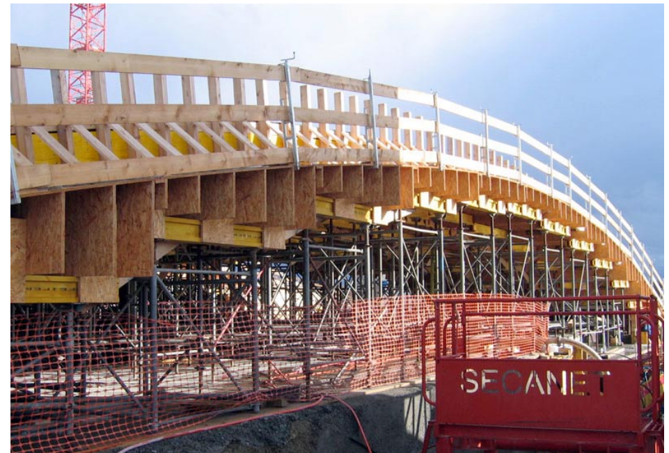
Die Holzschalung des EPFL-Learning-Centers basiert auf 10.000 individuell geformten Knaggen, die computergesteuert geschnitten wurden
