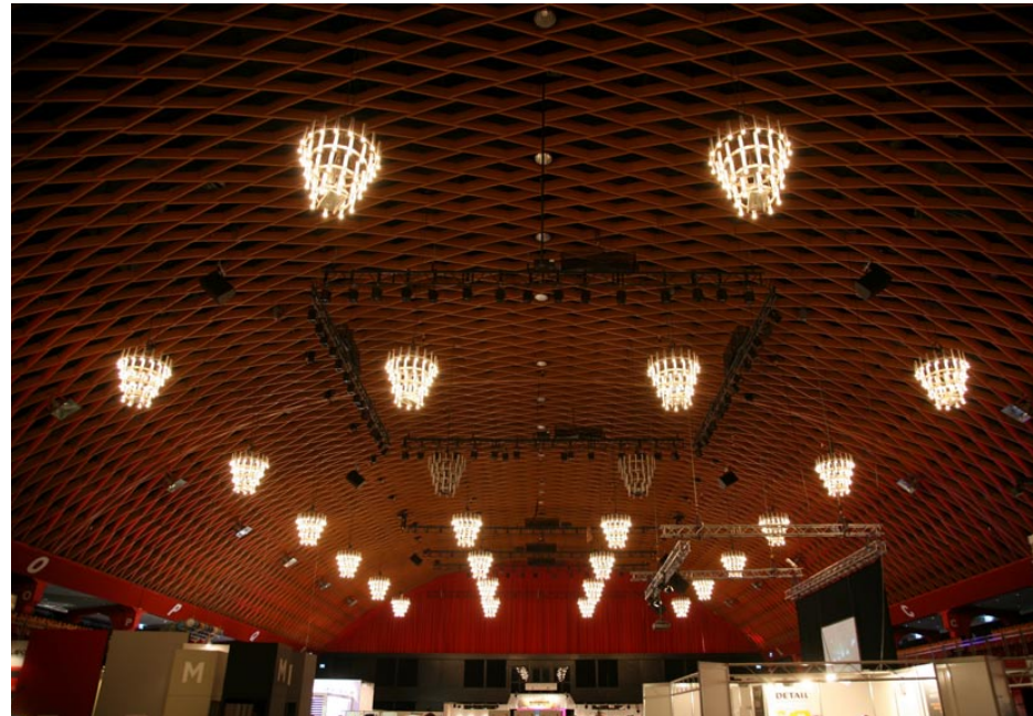
Die Stabkonstruktion der Halle Münsterland, Schauplatz der „architectureworld 2008“
