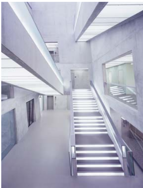
Treppe im Stadthaus Scharnhäuser Park, Ostfildern
