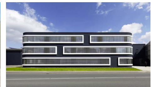
Verwaltung der Stadtwerke in Lemgo
