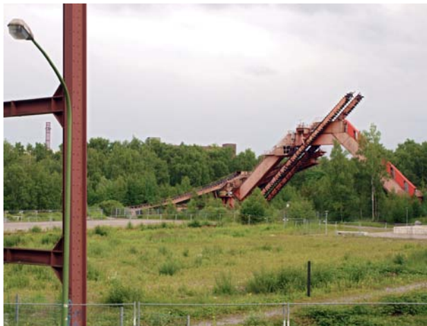
Brachfläche auf der ehemaligen Zeche Zollverein in Essen, wo auch das diesjährige Forum d'Avignon stattfand
