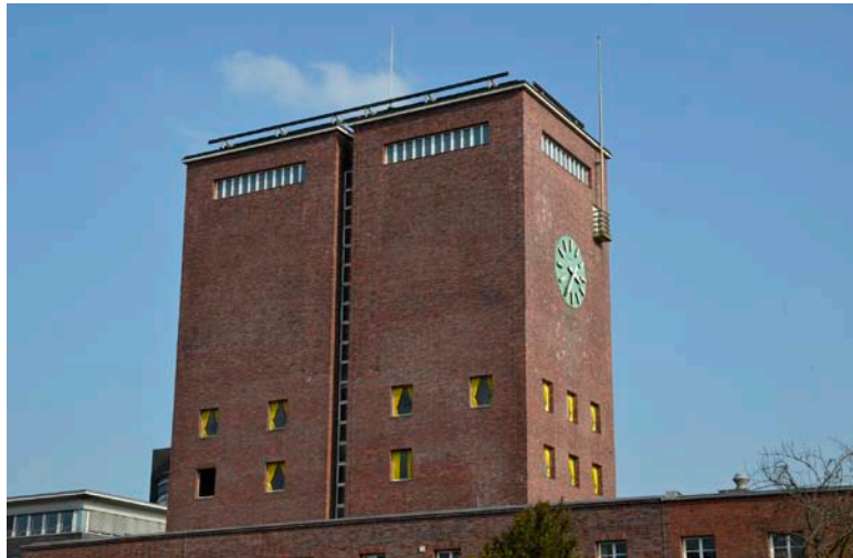
Arbeiten mit dem Ort: Umbau des Oberhausener Bahnhofsturms zur Kreativplattform kitev in Eigeninitiative des Ateliers Stark + Wnuczak
