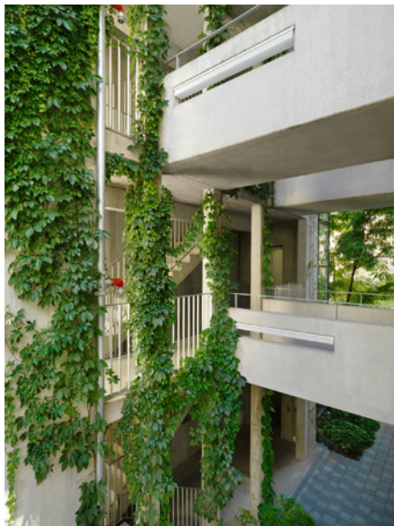
Die Verbindungsstege zwischen Treppenturm und Wohnungen, Fotos: Bernd Borchardt
