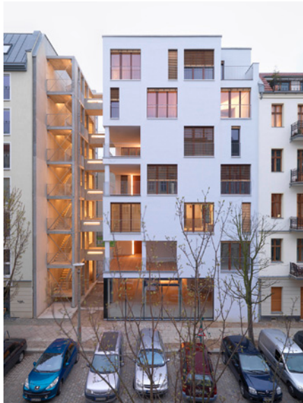
Baugruppenhaus E3 in Berlin-Prenzlauer Berg, Kaden + Klingbeil Architekten 2008
