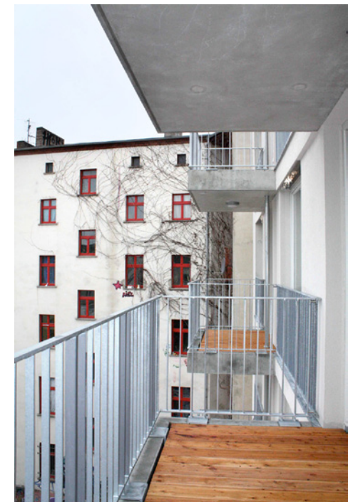
Detail der Straßenfassade Balkone auf der Gartenseite, Fotos: Beate Marvan
