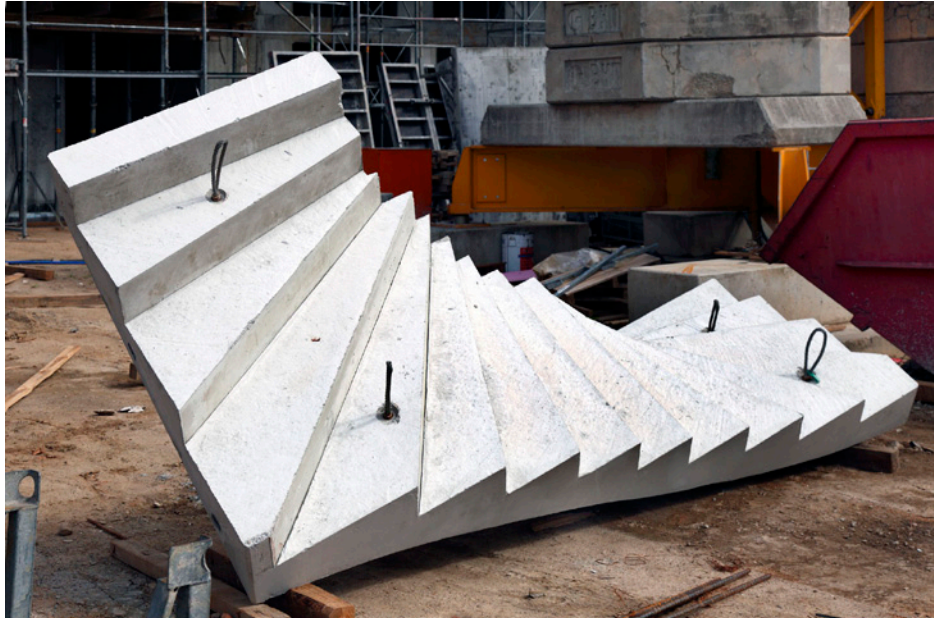
Momentaufnahmen einer Baugruppenbaustelle zwischen April 2011 und August 2012 Fotos: Thomas Spier
