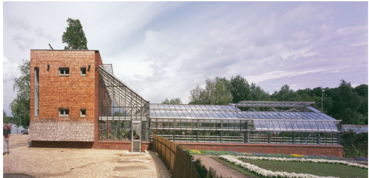
Die Schaugewächshäuser in Pankow (Fotos oben) und das Schaugewächshaus der Landschaftsgärtnerei in Waren/ Müritz (unten); beide Projekte wurden von Haas Architekten saniert. (Fotos: Dirk Altenkirch)
