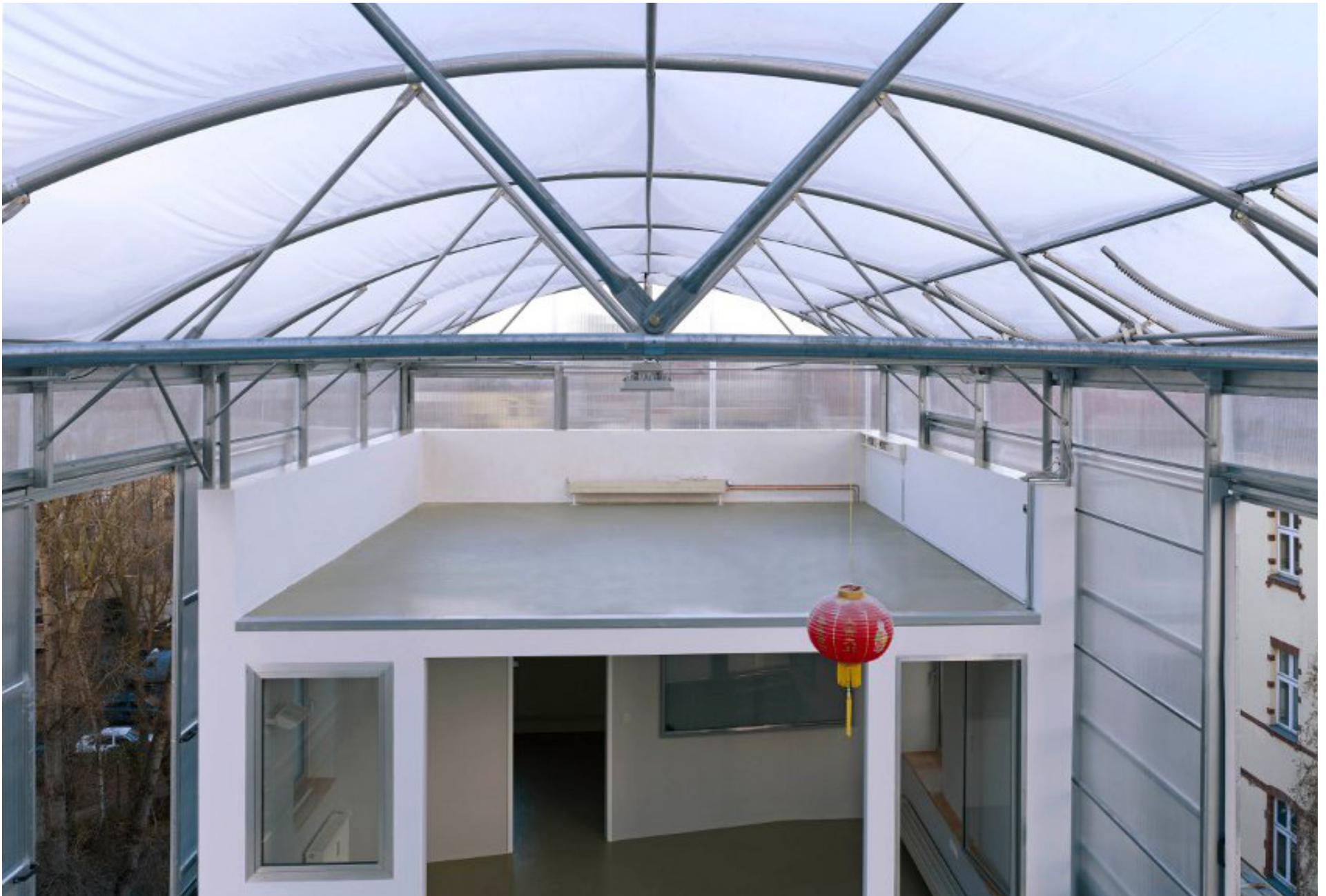
Hegemonietempel: Die Dachhaut besteht aus zwei Kunststofffolien, die mit Luft gefüllt sind und Wärme speichern – trotzdem leben die Bewohner mit den Jahreszeiten. (Foto: Frank Hülsbömer)
