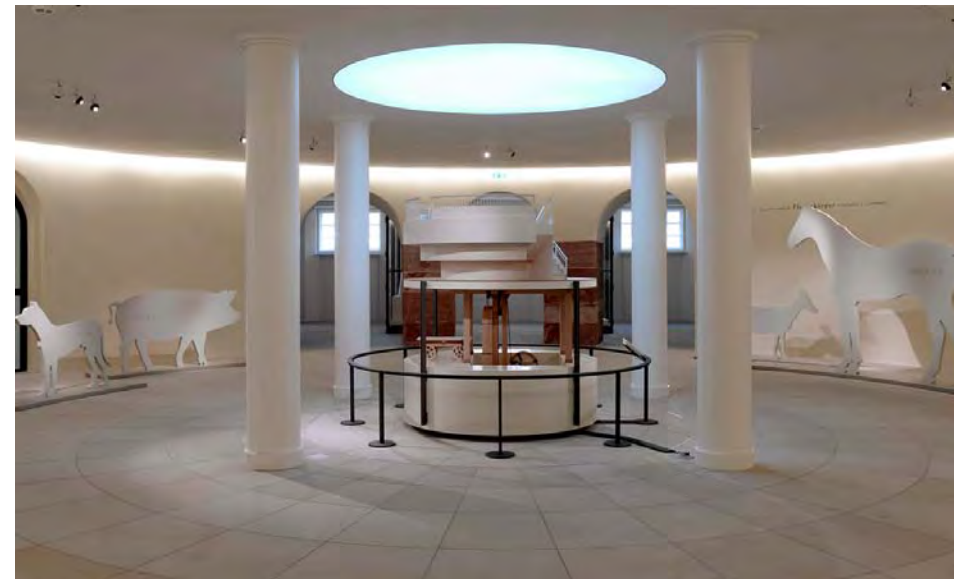
Raum unter dem Hörsaal nachher; aus gestalterischen Gründen wurden die nicht bauzeitlichen eckigen durch runde Stützen ersetzt
