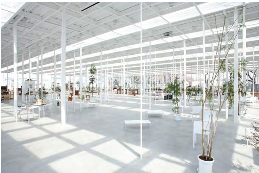
*Stützenwald: Die insgesamt 305 Stützen variieren im Längsquerschnitt zwischen 80 und 160 mm, in der Breite zwischen 16 und 62 mm*
