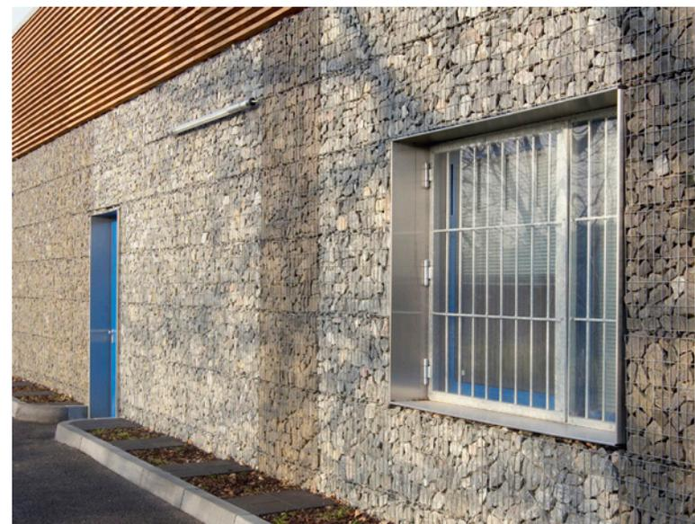
Ein Discounter mit besonderer Fassade: Die äußere Schicht besteht aus Gabionenkörben, die mit hellem Kalkstein und dunklen Basalt befüllt sind.
