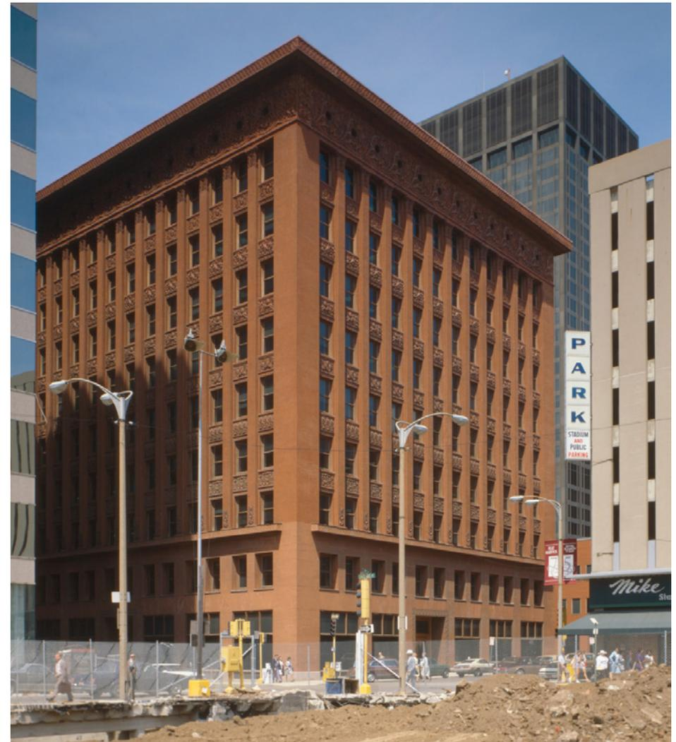
Das Wainwright Building in St. Louis (Adler & Sullivan, 1891) war eines der ersten Hochhäuser mit Stahlskelett, doch die Mauern wurden optisch wie tragende Elemente gestaltet. Die Mauerziegel unter dem Dachgesims wurden so bearbeitet, dass sie wie antike Säulenkapitelle wirken.
