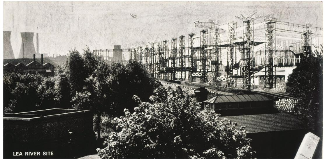
Oben: Fun Palace von Cedric Price. Durch bewegliche Wände und Dachpaneele kann das Gebäude nach Bedarf offen oder geschlossen gestaltet werden. Die Flexibilität der Struktur soll durch mechanische Vorrichtungen wie Rolltreppen und Rollsteige unterstrichen werden, welche die Bewegungen der Besucherströme lenken. (Abbildungen: Cedric Price Fonds / Canadian Centre for Architecture, Montréal)
