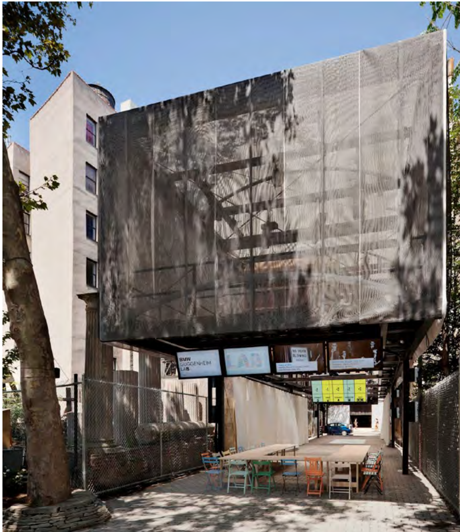
Blick in den Pavillon von der Houston Street. Die Fassade aus einem doppelten, halbtransparenten Kunststoffgewebe erzeugt einen subtilen Moiré-Effekt
