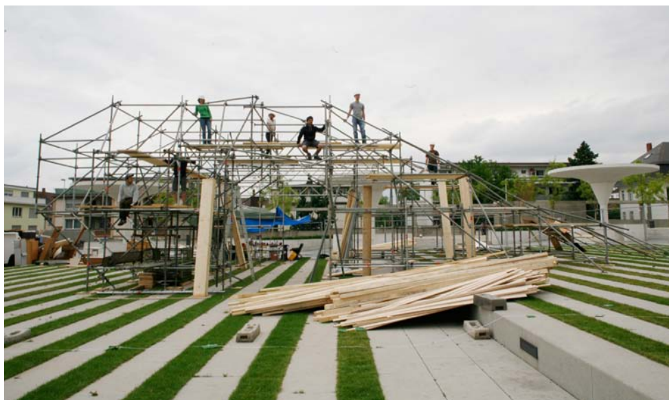
Als Unterkonstruktion für The Big Crunch dient ein Baugerüst. Fotos: raumlabor berlin
