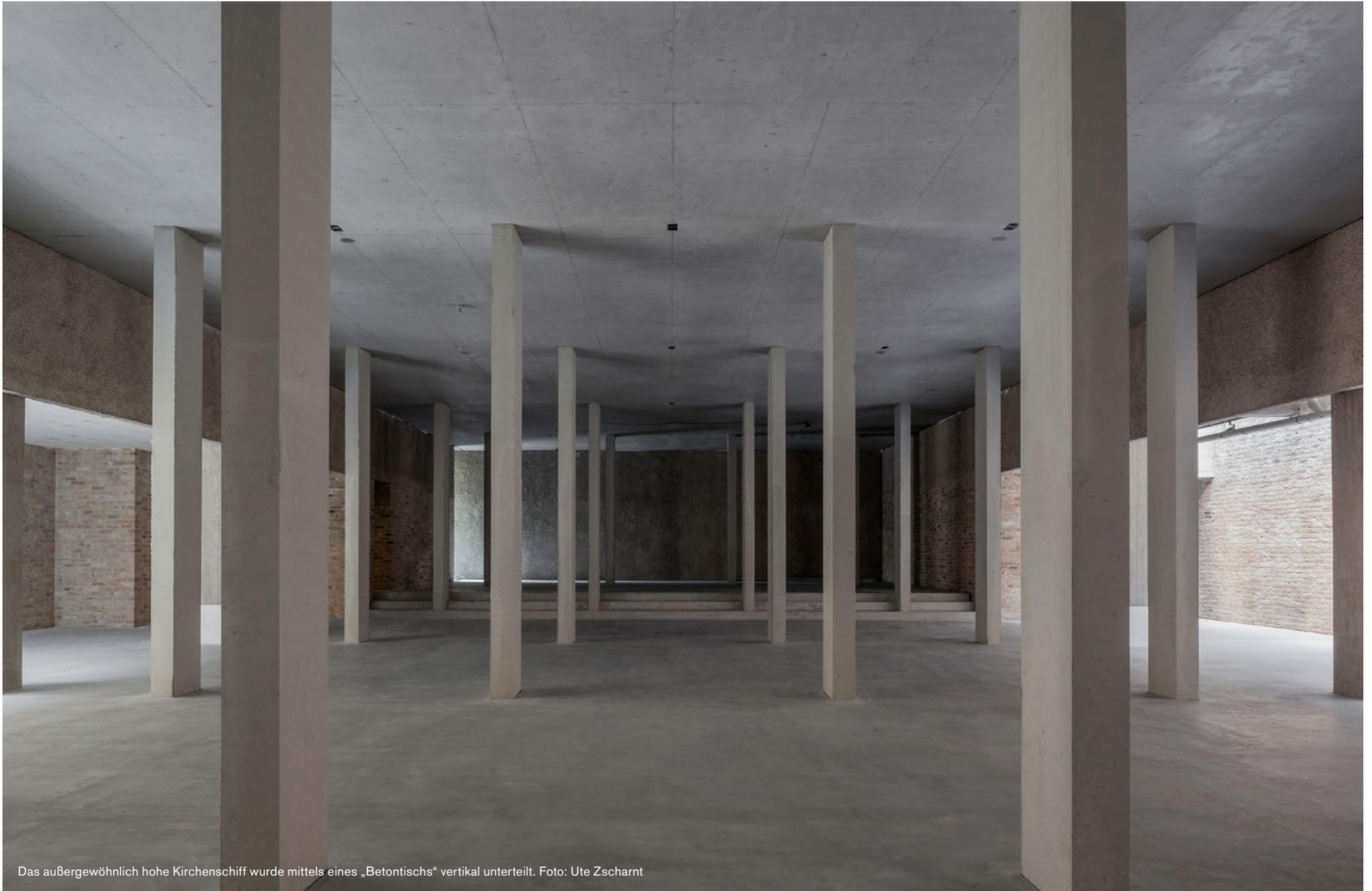
Das außergewöhnlich hohe Kirchenschiff wurde mittels eines „Betontischs“ vertikal unterteilt. Foto: Ute Zscharnt
