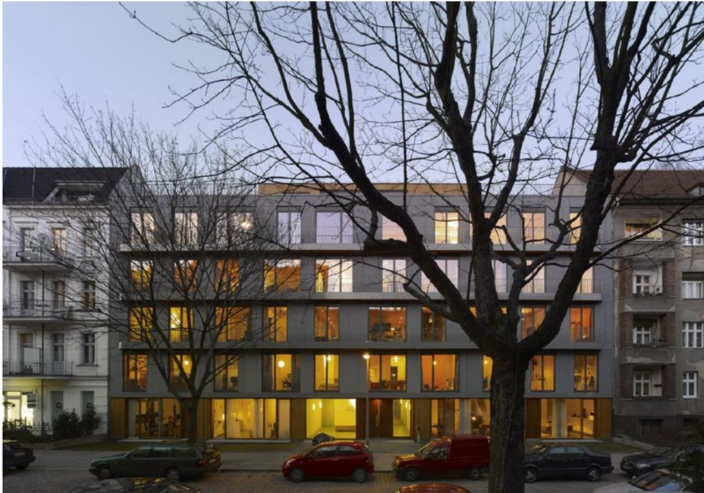
Perfektes Understatement: Das Holzhaus 3xgrün fügt sich in seine steinerne Berliner Umgebung ein, verheimlicht seine Konstruktionsweise aber nicht. Die schmalen Balkonbänder lassen erkennen, woraus das Gebäude eigentlich besteht, denn die hölzernen Deckenplatten wurden hier einfach von innen nach außen geführt. Architektur: ARGE Atelier PK, roedig . schop Architekten und Rozynski-Sturm Architekten, Foto: Stefan Müller
