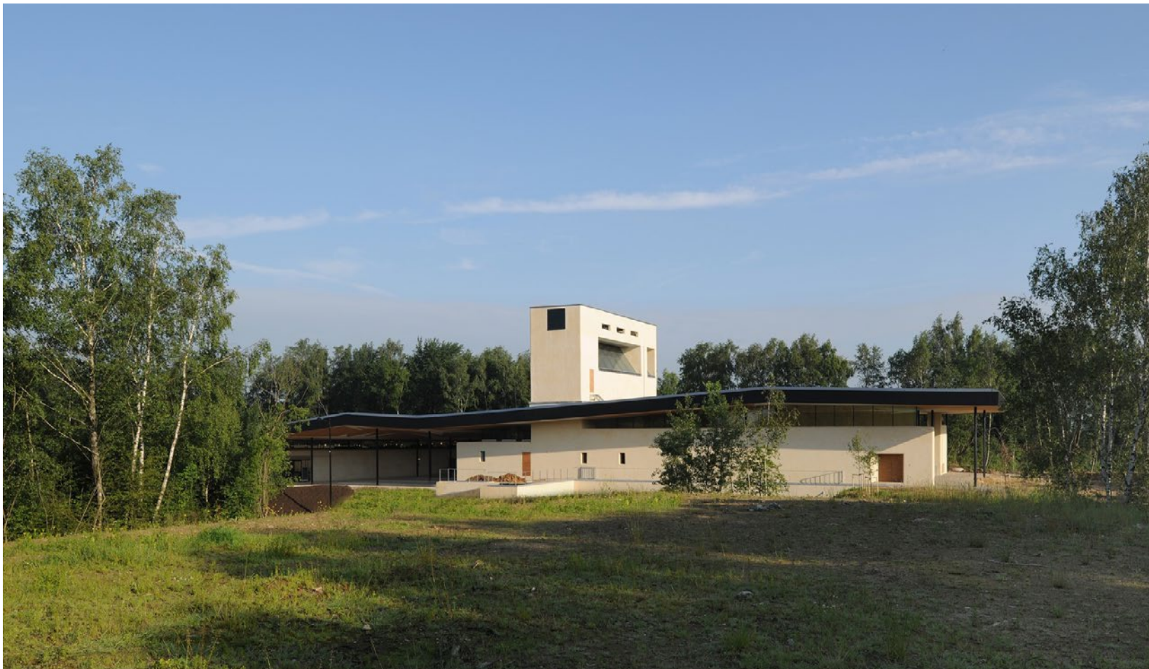
Beerdigungszentrum in Welkenraedt von 2010, Dethier Architecture (Liège), Fotos: Serge Brison
