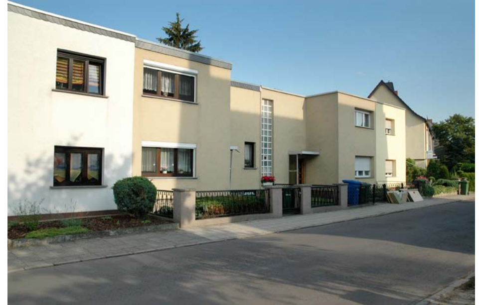
Walter Gropius: Sietö II, Ziegel, 2011. Die meisten Häuser von Gropius besteht es aus Schlacke- betonsteinen, zwei Arbeiter fertigten die Steine auf der Baustelle im Akkord an – eine neue Verfahrens- weise. Daneben gab es auch eine Reihe Ziegelbauten, die miteinander verglichen wurden. (Fotos: Ursula Achternkamp, 2011, Stiftung Bauhaus Dessau)
