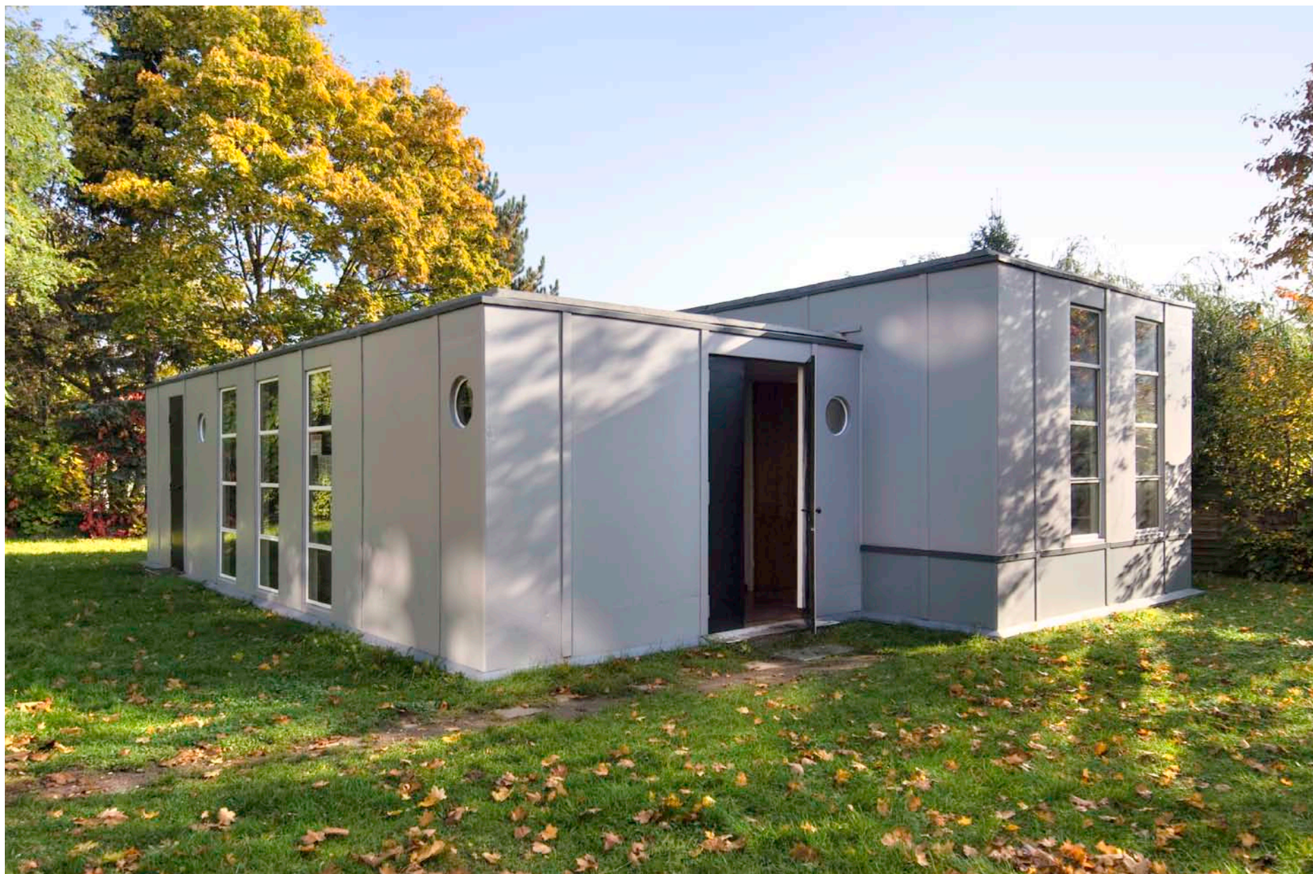
Das Stahlhaus von Georg Muche und Richard Paulick (1926/27) wurde mittlerweile mit Styrodur nachgedämmt. Original ist noch das Bullauge der Damentoilette (neben dem Eingang). (Foto: 2008, Stiftung Bauhaus Dessau)
