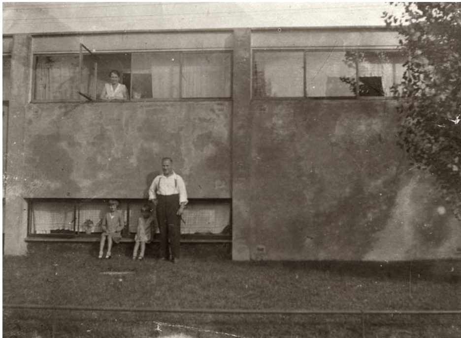
Elfriede Kruse wohnte als Kind mit ihrer Familie in einem Haus vom Typ Sietö IV. Deutlich sichtbar ist die überdimensionierte Brüstungshöhe der Fenster: Ihre Mutter brauchte eine Trittleiter, um aus dem Fenster zu sehen.
