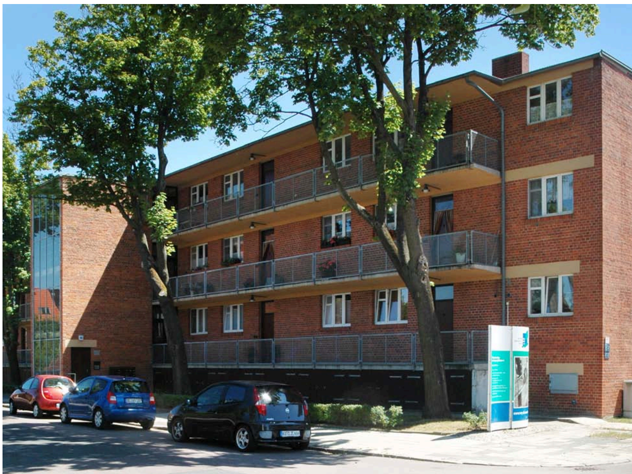
Die Laubenganghäuser von Hannes Meyer entstanden in Klinkerbauweise mit auskragenden Laubengängen. Eine Drahtglasfassade leitet Tageslicht ins Treppenhaus. (Foto: Ursula Achternkamp, 2011, Stiftung Bauhaus Dessau)
