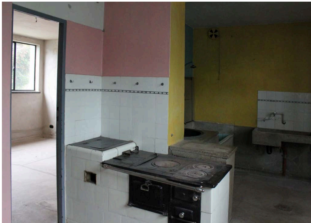
Haus Anton (1927) entspricht dem Typ Sietö I. Das Gebäude wurde denkmalgerecht saniert und für Besucher geöffnet. Links im Bild eine Tür mit Original-Metallrahmen. Hinter dem Herd befindet sich die „Räucherammer“, dahinter eine Badewanne, die mittels Deckel zur Arbeitsfläche verwandelt werden kann. (Foto: Myrta Köhler)
