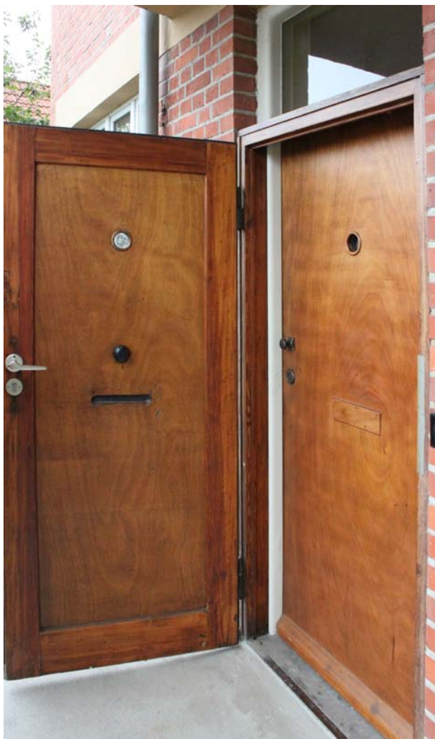
Die Original-Wohnungstüren der Laubenganghäuser wurden vor einigen Jahren restauriert und sind bis heute an Ort und Stelle, die Fenster wurden durch moderne Plastikvarianten ersetzt.
