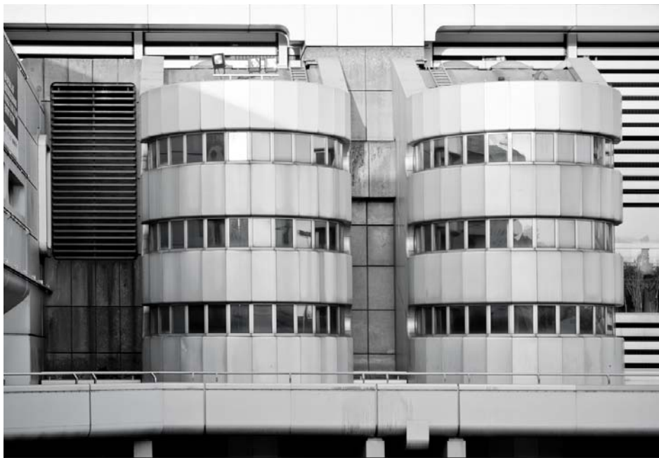
Die Fassade des ICC wurde seit fast 20 Jahren nicht mehr gereinigt. Fotos: Matthias Jakoby
